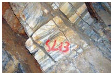
雅砻江锦屏水电站坝址左岸深部卸荷裂隙
