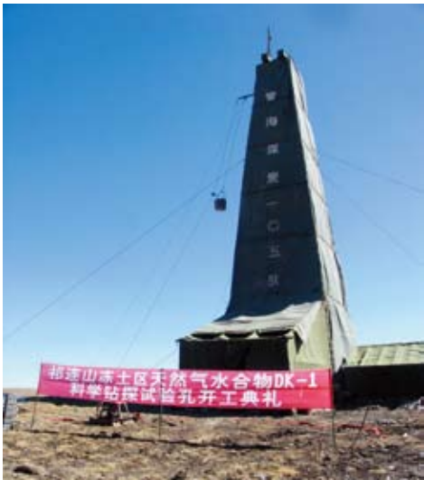
祁连山冻土区天然气水合物 DK-1 科学钻探试验孔施工现场
